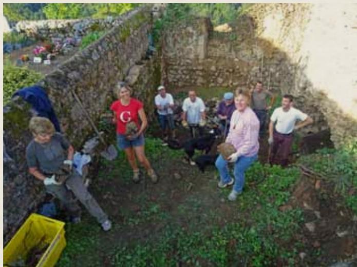
La mise à disposition d'engins et de matériel professionnel a considérablement allégé la tâche des bénévoles qui s'est poursuivie par le nettoyage et la réfection des joints ; certains se sont même essayés au métier de maçon, en restaurant des parties de mur. Ensuite, dès que la chaux a été sèche, il a fallu brosser les joints pour leur donner un aspect vieilli.
